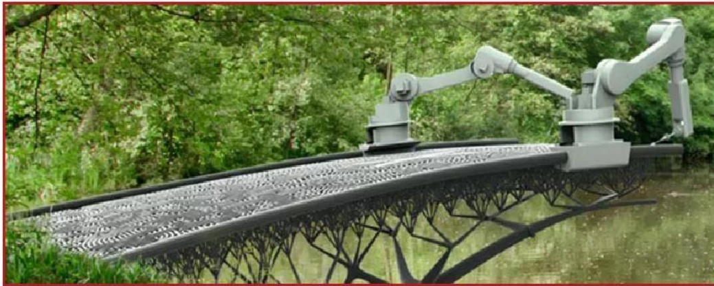
Xây cầu bằng công nghệ in 3D
