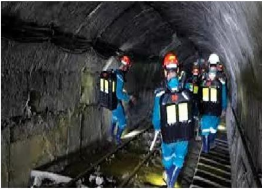
Công nhân làm việc trong các đường hầm phải đeo bình dưỡng khí (chứa oxygen)
