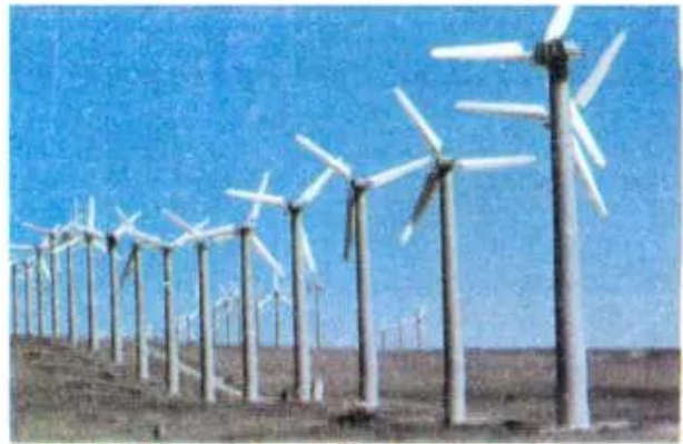
Hình 32.3. Trạm phát điện năng lượng gió
