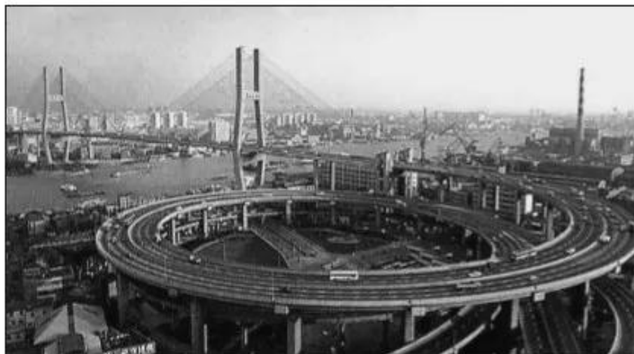
Hình 11. Cầu lớn Nam Phố, Thượng Hải
