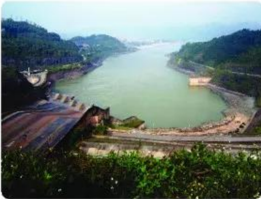
a) Đập thủy điện
