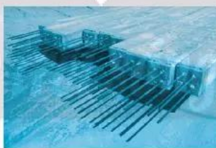
Đúc thành trụ cốt thép
