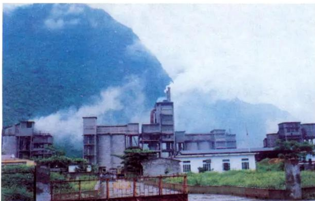
② Nhà máy xi măng Hà Giang
