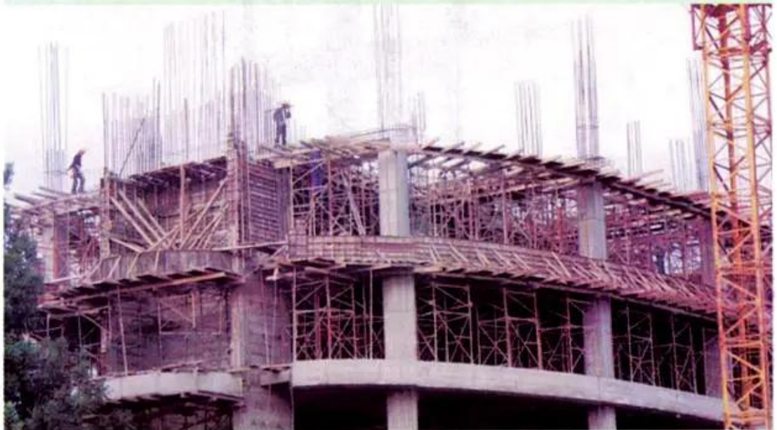
③ Đổ bê tông cốt thép
