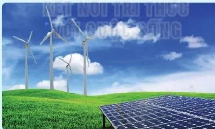
Hình 14.1. Hệ thống điện gió và điện mặt trời
