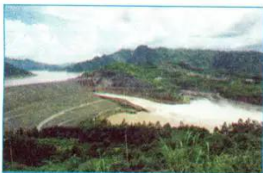
Hình 33.2. Đập thủy điện Hoà Bình trên sông Đà (tỉnh Hoà Bình)
