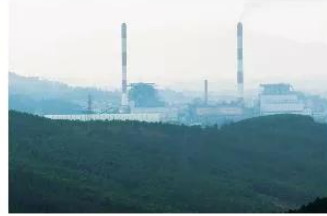
▲ Hình 10.8. Nhà máy nhiệt điện
