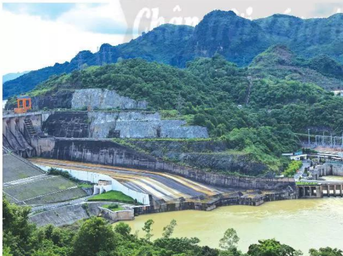
c) Nhà máy thủy điện (Hoà Bình)
