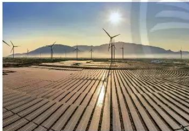
f) Trạm phát điện gió
