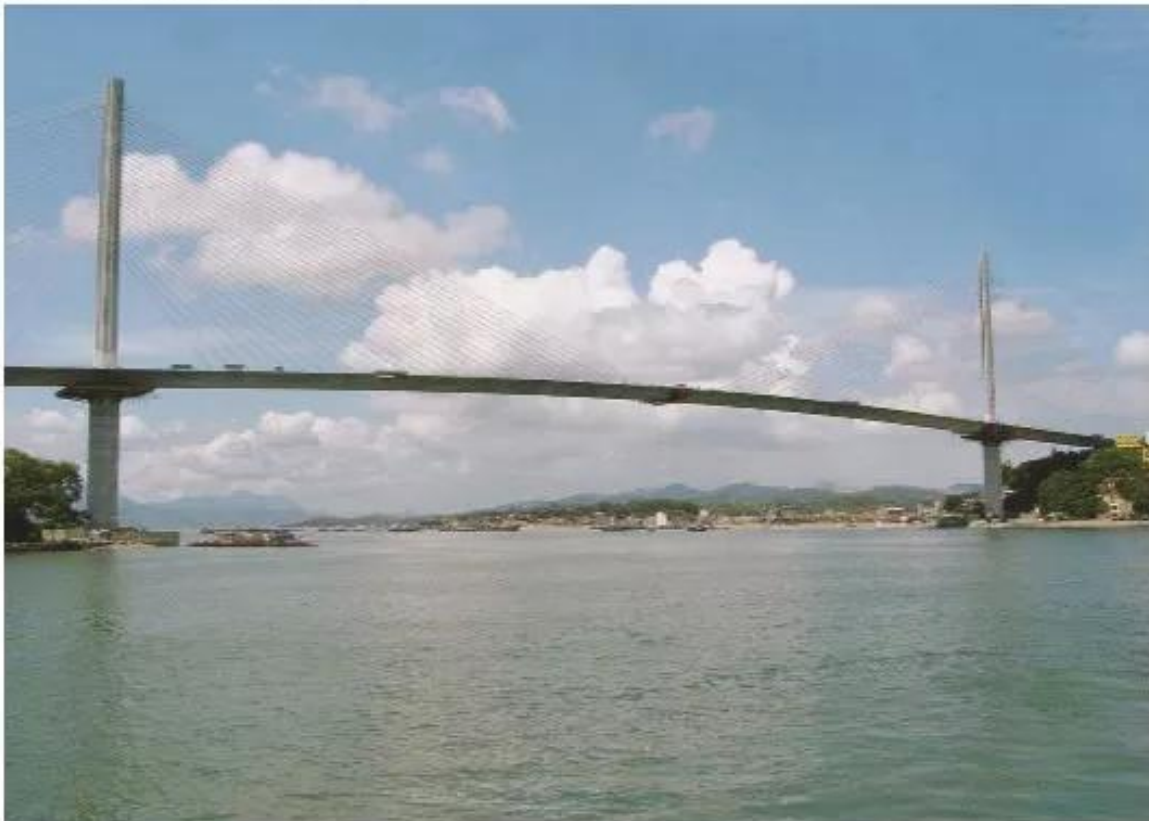
Cầu Bãi Cháy (Quảng Ninh)
