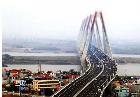
Hình 1.6. Cầu Nhật Tân, Hà Nội (xây dựng từ năm 2009 đến năm 2015)
