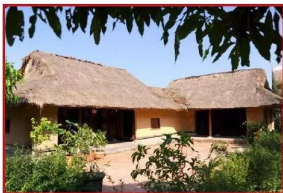
Nhà mái lá miền Trung với kiến trúc hai lớp mái và vật liệu sáng tạo từ đất, tre và lá. Đây là căn nhà thông minh bởi sự thích nghi hài hoà với thiên nhiên miền Trung vốn vừa nắng nóng vừa nhiều bão lũ.
